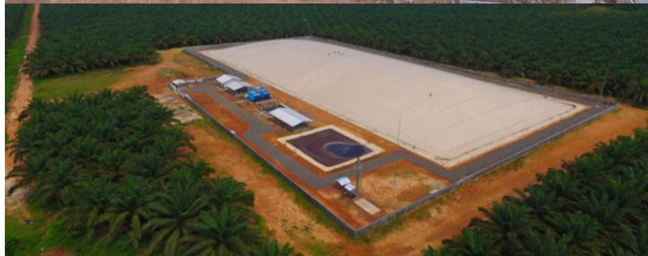
Gambar: (Atas) Pabrik biogas untuk co-firing boiler (Sumber—PT Ecodey Agro Energi). (Bawah) Pembangkit Listrik Tenaga Biogas Semilar (Sumber—PT Karya Mas Energi).
