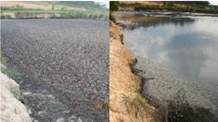
Gambar: Proses pengolahan scum menggunakan Microbe-Lift di kolam anaerobik (Sumber: Planetbiru).
