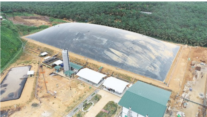
Gambar: Pembangkit Listrik Tenaga Biogas PT Swadaya Multi Prakarsa (Sumber-PT Elmoz Geo Solusi).
