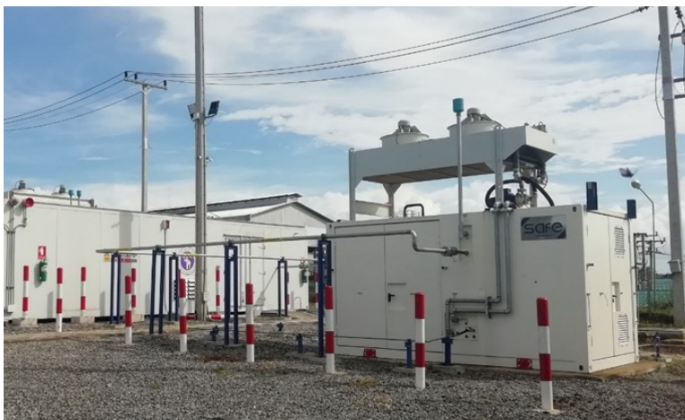
Gambar: Sistem upgrading biogas dan skid kompresi (Sumber–Safe S.p.A).
