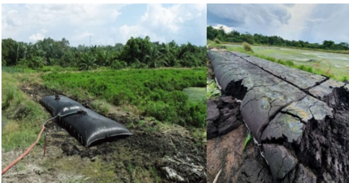
Gambar: (Kiri) Proses pengisian C-tube dan (kanan) padatan kering yang diperoleh (Sumber –PT Elmoz Geo Solusi).
