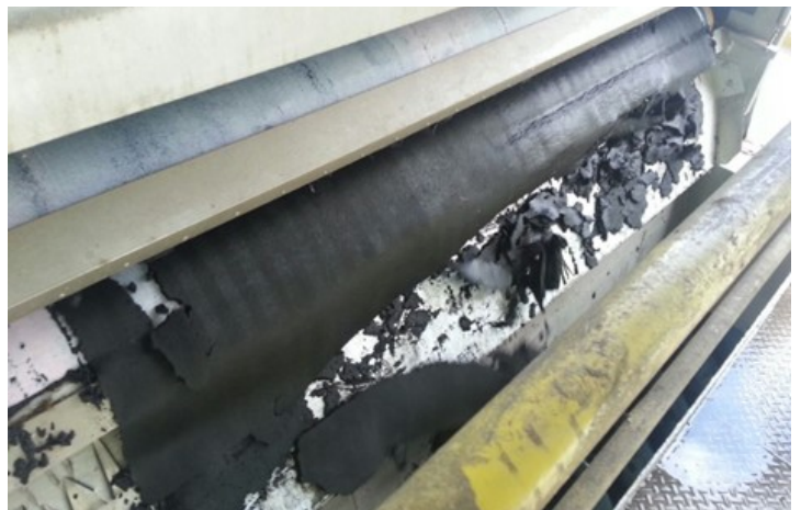
Gambar: Penghilangan kandungan padatan dengan sistem dewatering (Sumber –Green Mark Projects Sdn. Bhd.).
