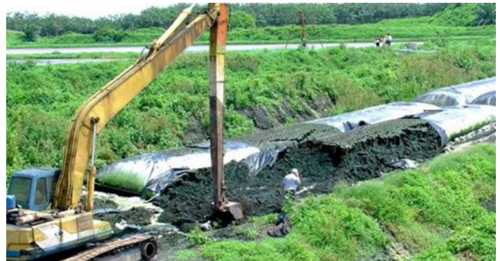
Gambar: Lumpur POME yang diolah dengan Dewatering Geotube ® TenCate (Sumber: TenCate Geosynthetics).
